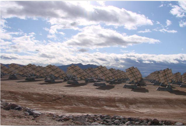
Nellis AFB, Las Vegas, NV 14 MW SunPower T0/T20 Tracker
