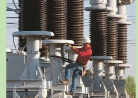
Transmisión y distribución
