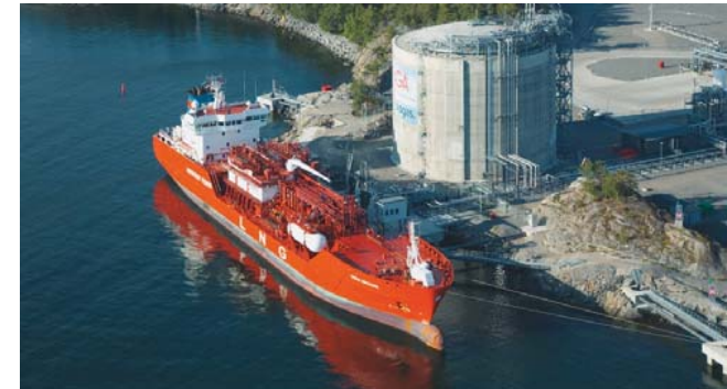
LNG carrier machinery
